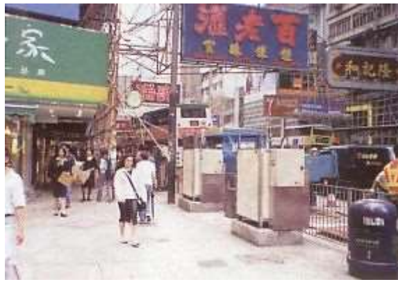
位於銅鑼灣的路邊監測站，須以「拆件」安裝
